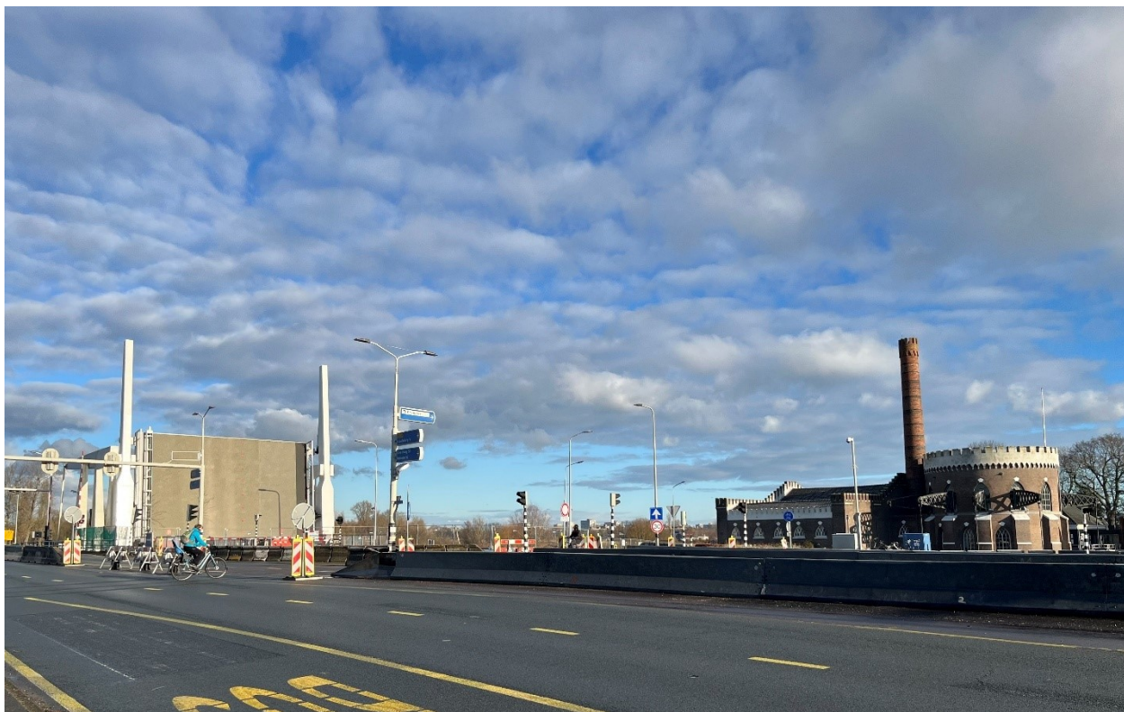
Figuur 1 werkzaamheden Cruquiusbrug, januari 2025, foto Jelle Blanken
