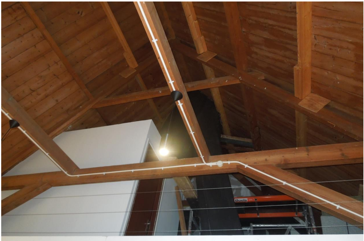
De kapconstructie in het woonhuis uit de bouwtijd.
