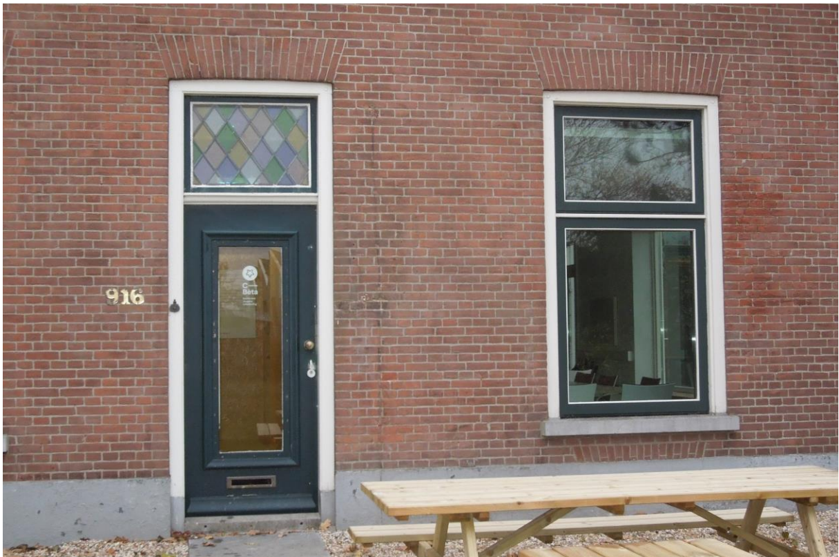
De voordeur met bovenlicht en H-venster, beiden onder een gemetselde strek. Onder het venster de gemetselde strek van het voormalige keldervenster.
