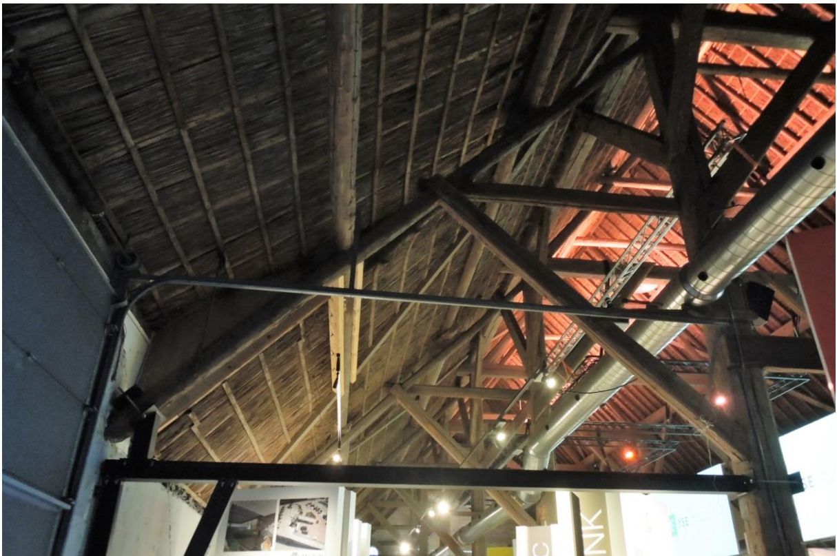
De draagconstructie van de zijbeuken. De stalliggers zijn vervangen voor een metalen constructie.
