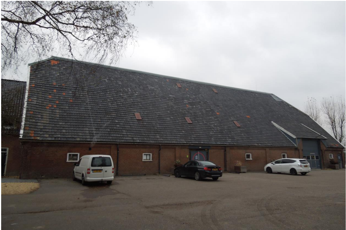
De rechter zijgevel van de schuur.
