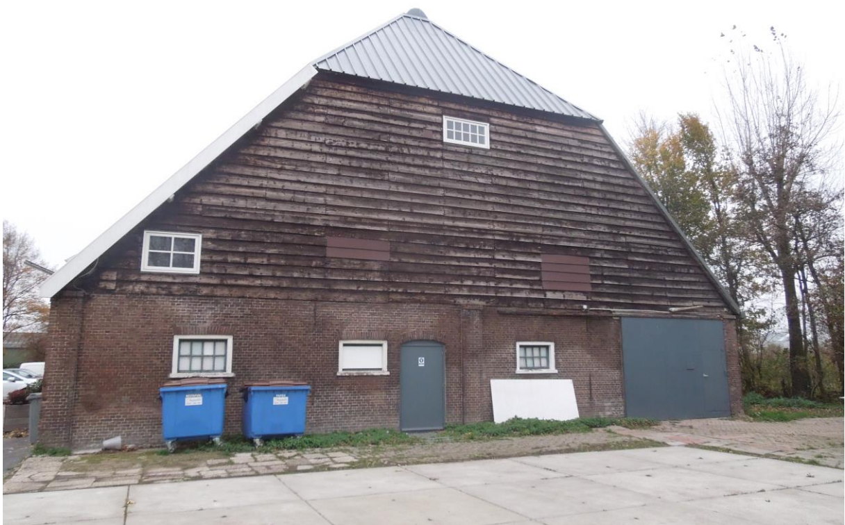
De achtergevel bestaande uit metselwerk en potdekselwerk.
