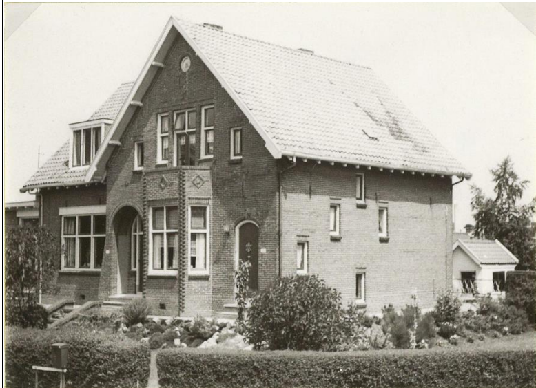
De directeurswoning in 1978, gezien vanaf de Kruisweg. Hierop is een rijke tuinaanleg te zien. Ook is de verhoogde ligging van het huis goed zichtbaar. [Noord-Hollands Archief]
