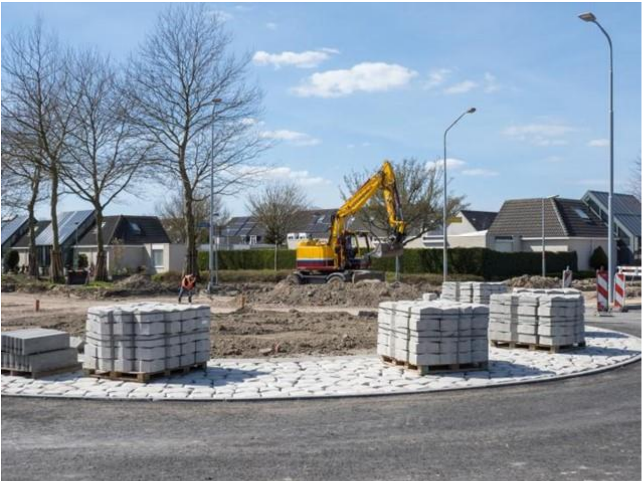
Aanleg rotonde kruising Venneperweg en Oosterdreef
