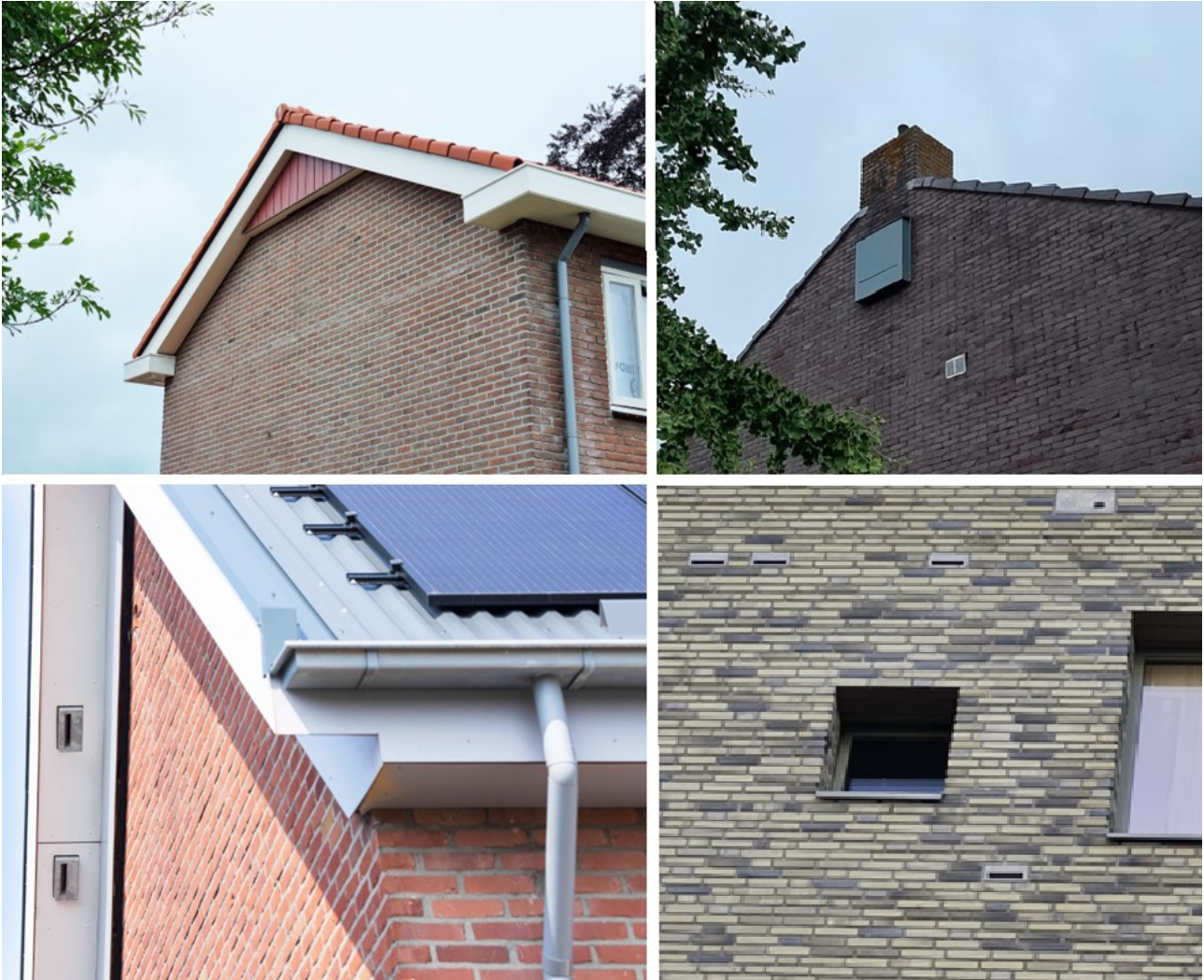
Figuur 3.1 Een aantal voorbeelden van vleermuisvoorzieningen. Met de klok mee: gevelbetimmering (onder overstek), opbouwkast, inbouwkast onder/in overstek. (Foto's: www.unitura.nl)
