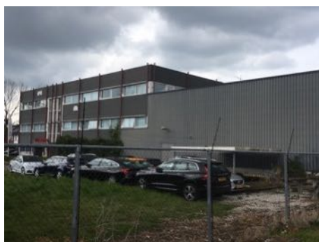
Figuur 4. Gebouw nr. 1 aan de Wijkmeerstraat 15.
