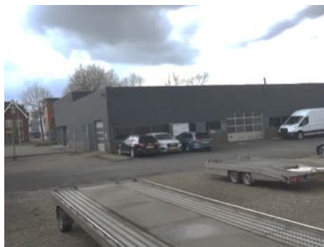
Figuur 5. Gebouw nr. 2 aan de Wijkmeerstraat 19-21.
