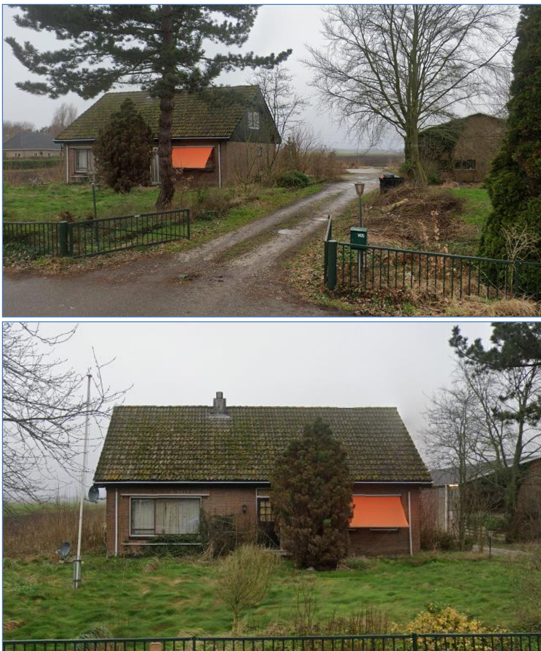
Figuur 2.1 en 2.2: Huidige situatie, aanzicht vanaf de IJweg 1435 (Bron: Google Maps)
