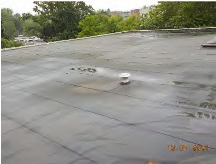
Foto 7: Bron B03, asbestvrije dakbitumen, 3 lagen
