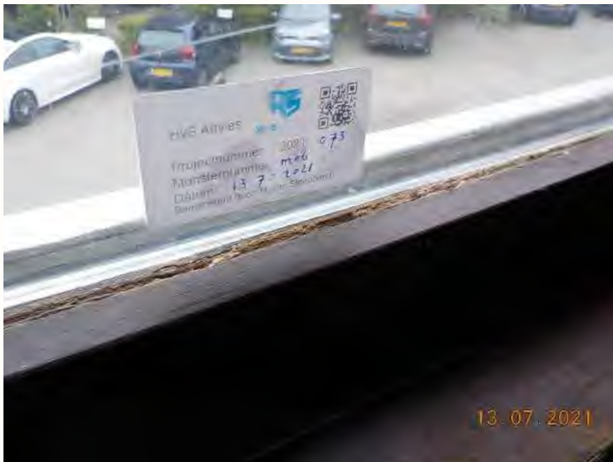
Foto 11: Bron B04, asbestvrije beglazingskit
