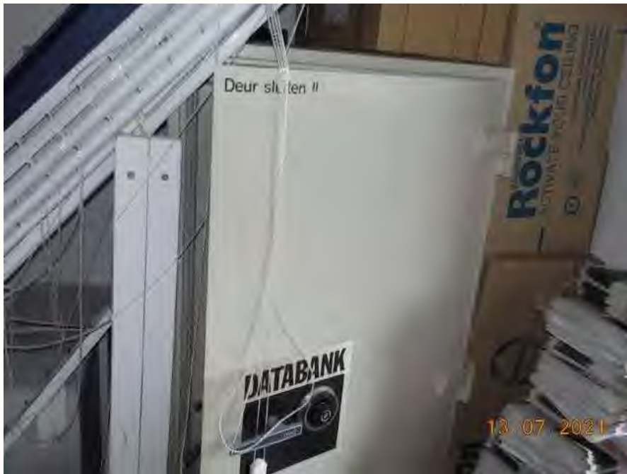
Foto 1: Bron B01, kluis met mogelijk asbesthoudende isolatie
