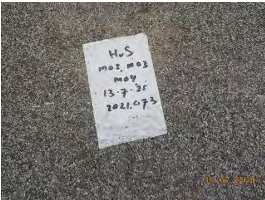
Foto 9: Bron B03, asbestvrije dakbitumen, 3 lagen
