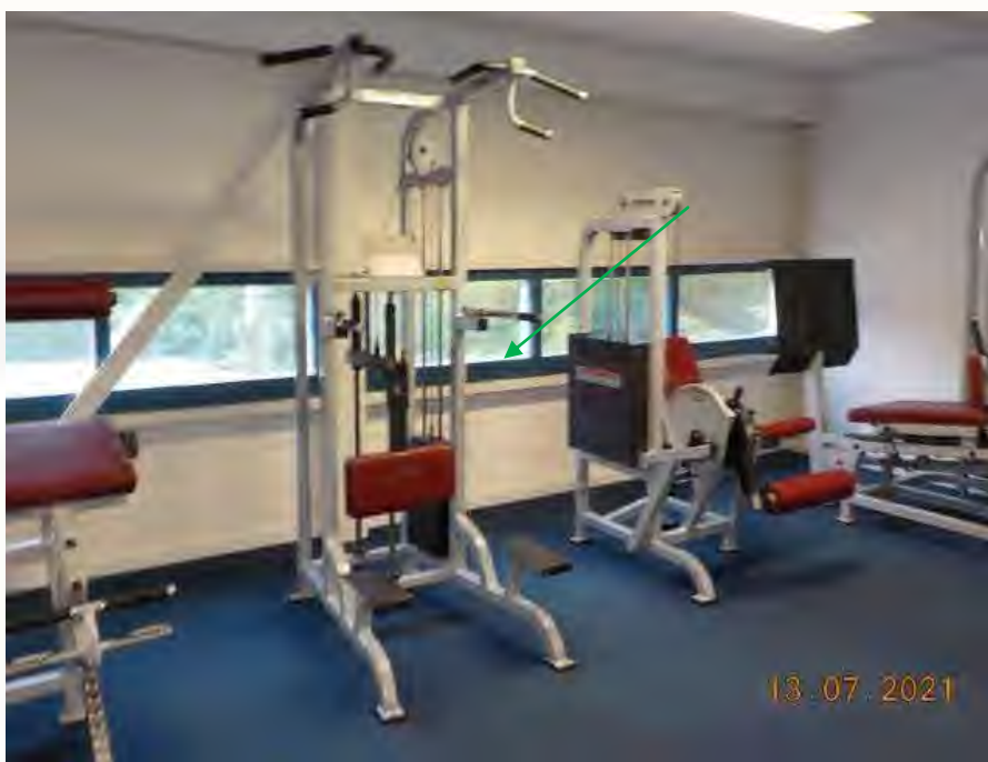
Foto 12: Bron B04, asbestvrije beglazingskit
