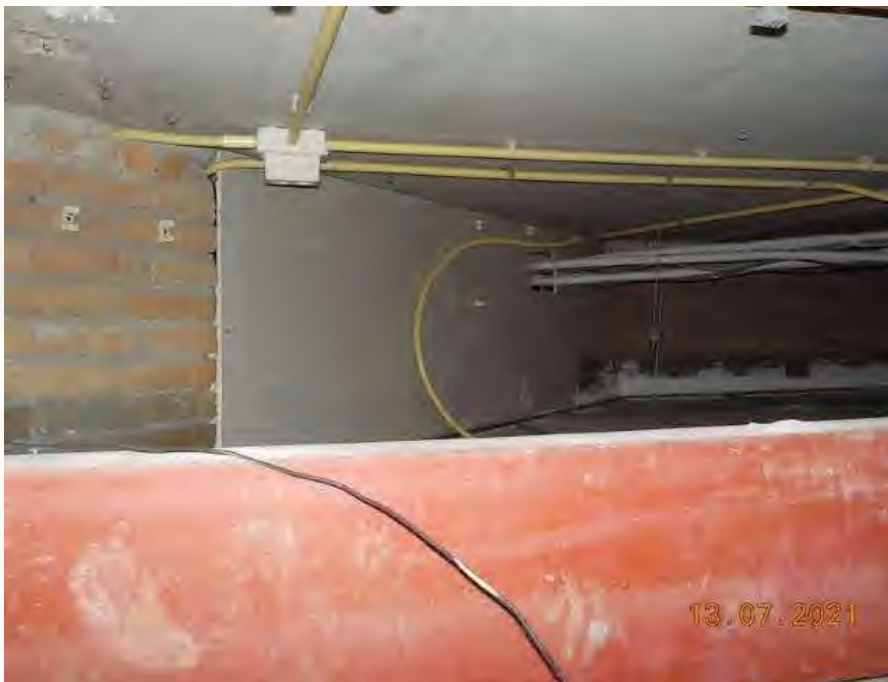
Foto 18: Asbestvrije gipsbeplating als brandscheiding
