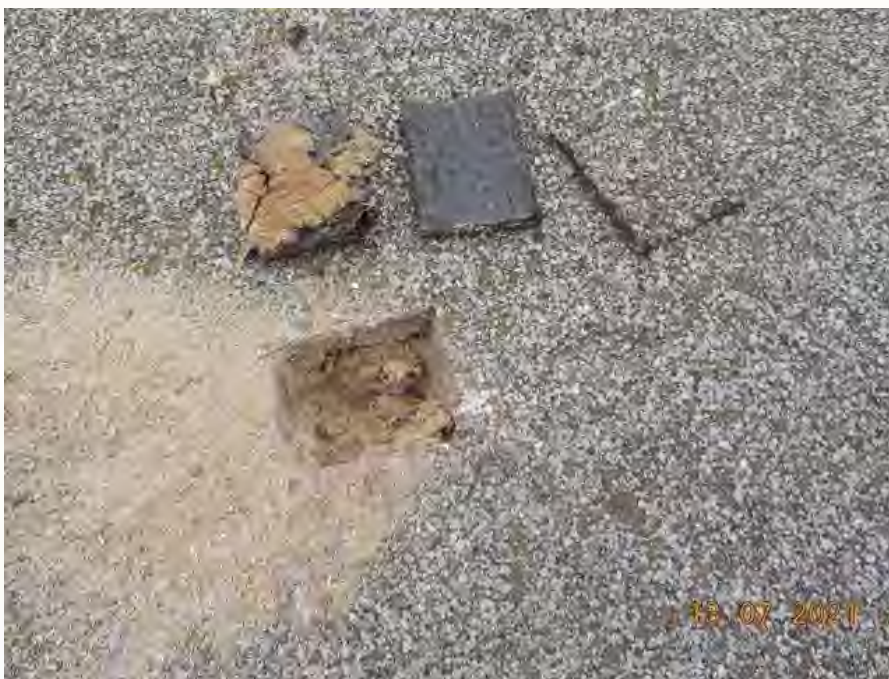
Foto 8: Bron B03, 3 lagen asbestvrije dakbitumen
