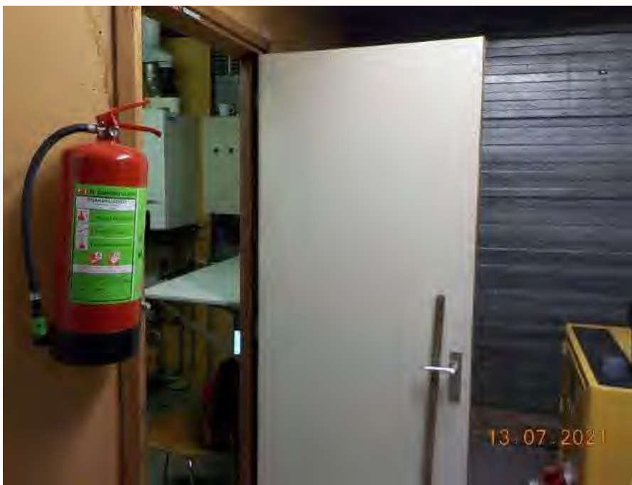
Foto 16: Brandwerende beplating, cv deur verwijderd, geen restanten aangetroffen.
