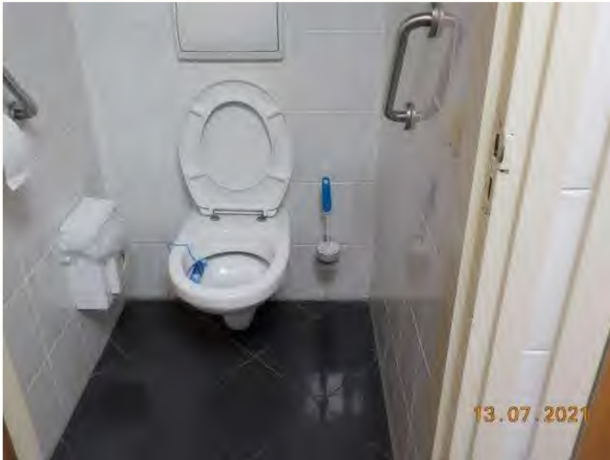
Foto 17: Moderne en nieuwe wandtegels
