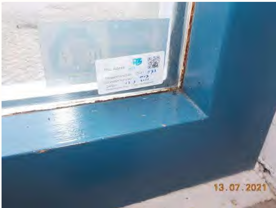
Foto 13: Bron B04, asbestvrije beglazingskit
