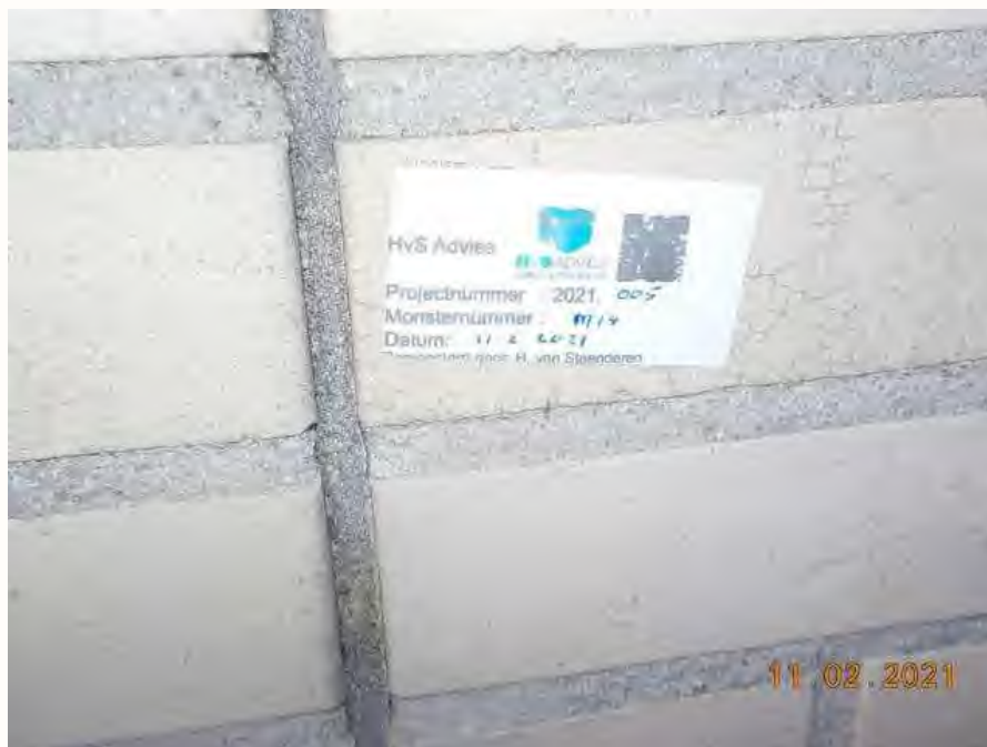
Foto 23: Bron B11, asbestvrije dilatatievoeg, kit
