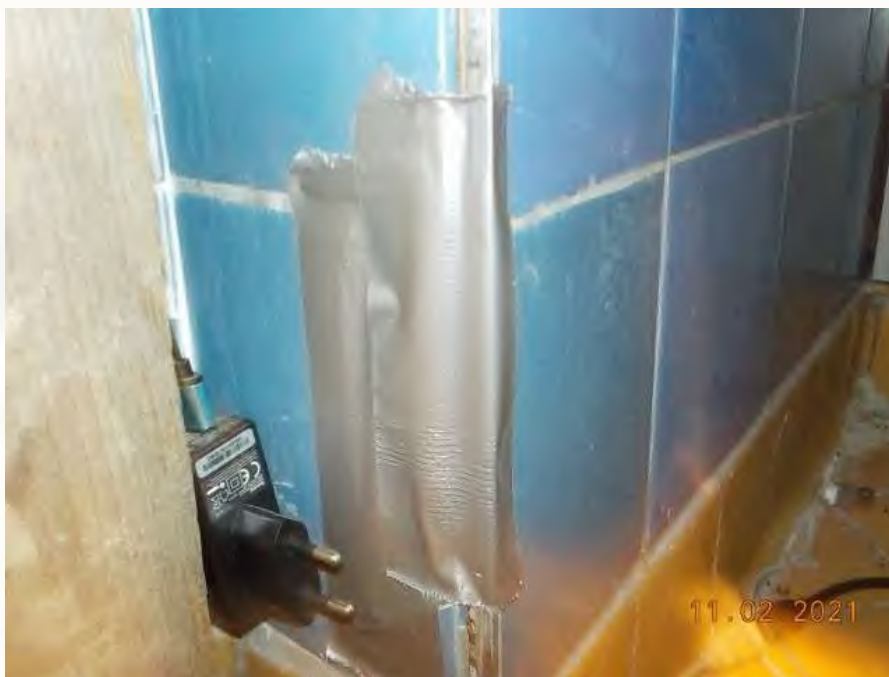
Foto 16: Bron B07, asbestvrije tegellijm
