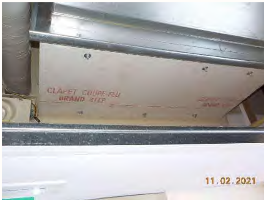
Foto 17: Bron B08, asbestvrije brandklep beplating
