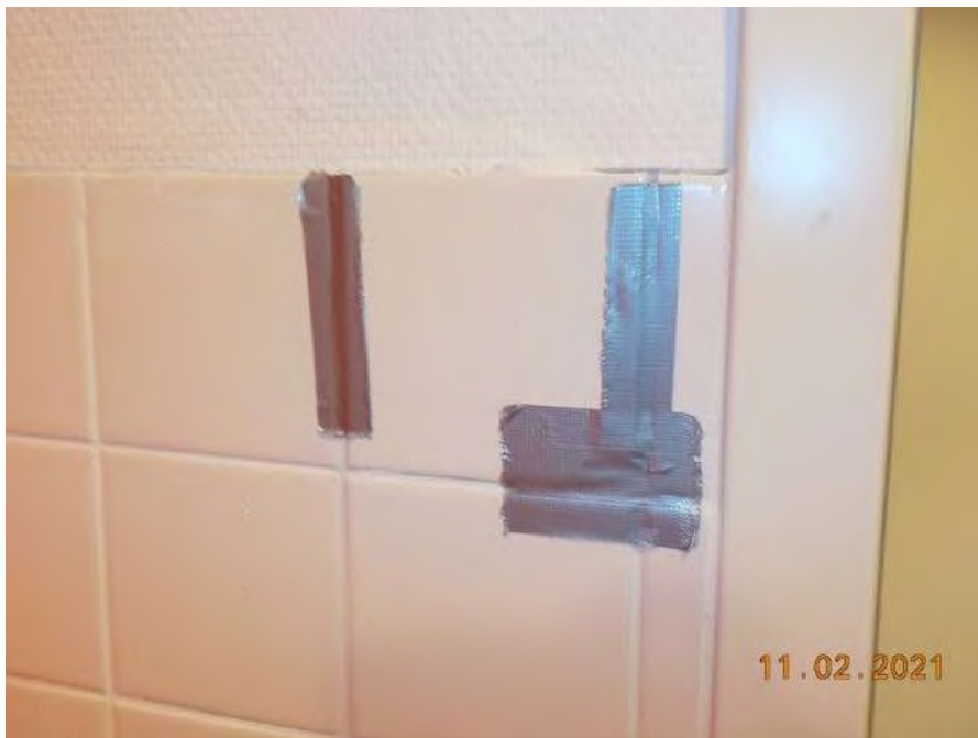
Foto 15: Bron B07, asbestvrije tegellijm
