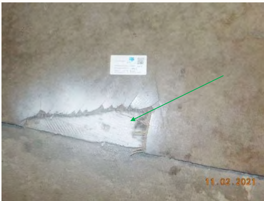
Foto 10: Bron B04, asbestvrije vloerafwerking, dakopbouw
