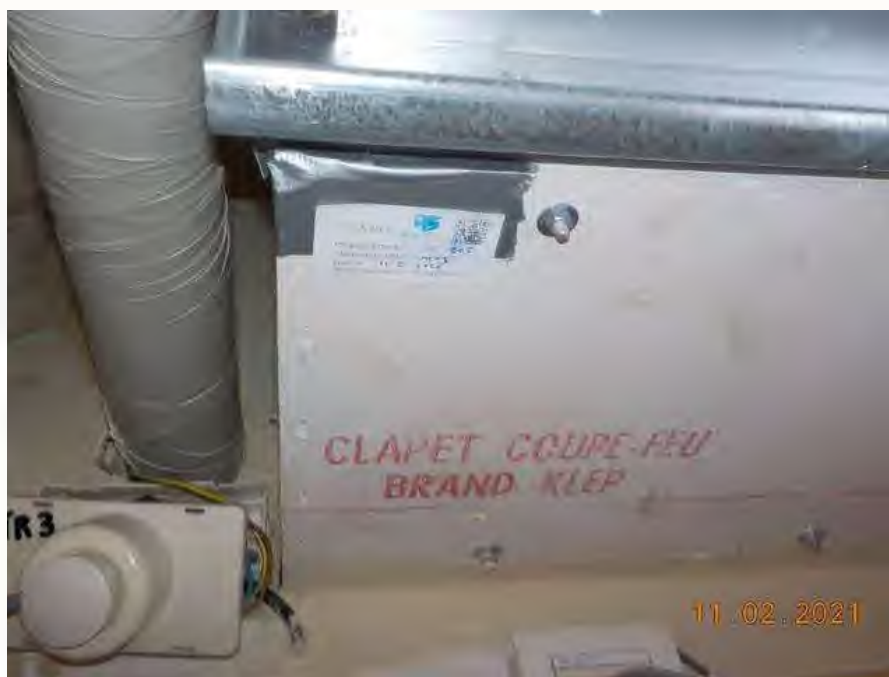
Foto 18: Bron B08, asbestvrije brandklep beplating
